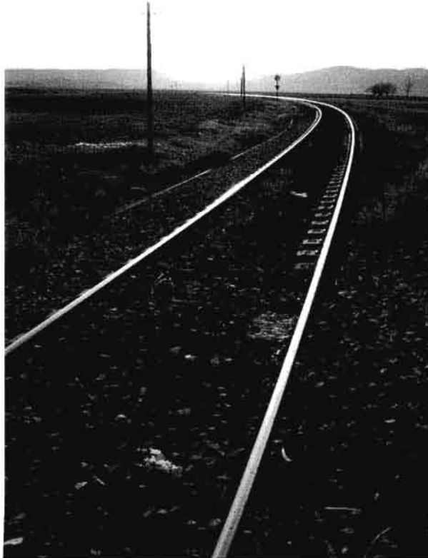
15: VÍA FÉRREA A LA SALIDA DE SANTA EULALIA DIRECCIÓN A OJOS NEGROS. (Foto: Diego Arribas)
