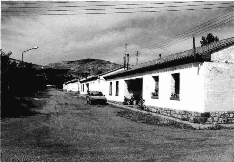
14: VIVIENDAS DE OBREROS DEL BARRIO CENTRO DE SIERRA MENERA. (Foto: Diego Arribas)
