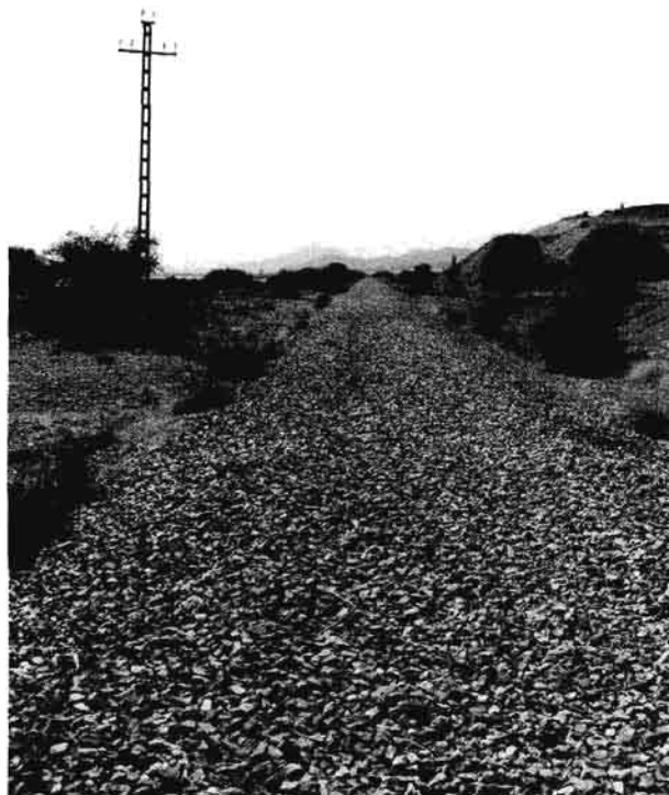
17: EL MISMO TRAMO, YA DESMANTELADA LA VÍA, EN 1998. (Foto: Diego Arribas)
