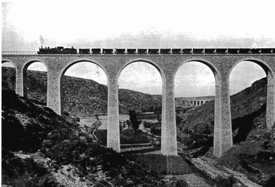
6: VIADUCTO DE ALBENTOSA, DE 160 M. DE LONGITUD, 5 ARCOS DE 20 M. DE LUZ Y 2 DE 10 M. LA ALTURA MÁXIMA EN EL CENTRO ES DE 48 M. (Foto: Sierra Menera)
