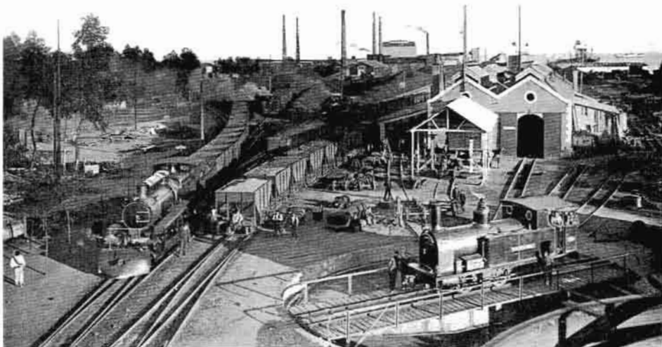
7: VISTA PARCIAL DE LA ESTACIÓN DE LLEGADA A PUERTO SAGUNTO EN 1910. (Foto: Sierra Menera)
