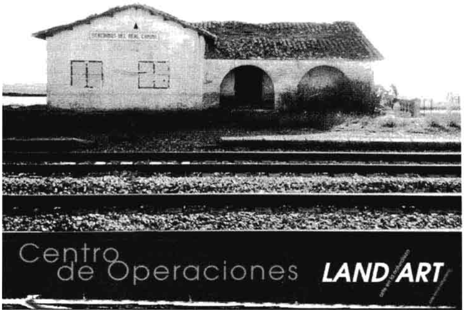
25: APEADERO DE BERCIANOS DEL CAMINO ANTES DE SU REHABILITACIÓN. (Foto: Centro de Operaciones Land Art "El Apeadero")
